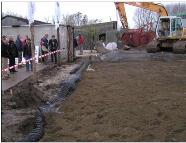
Abbildung 8. Aufbau des Großversuchs, Geogitter in beide Richtungen eingebaut und noch nicht zurückgeschlagen.
